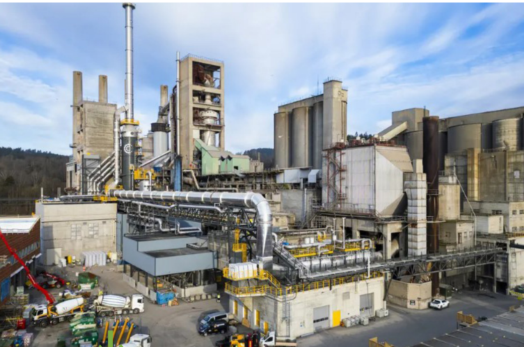
Slika 1: CCS postroj integriran v tovarni cementsa
