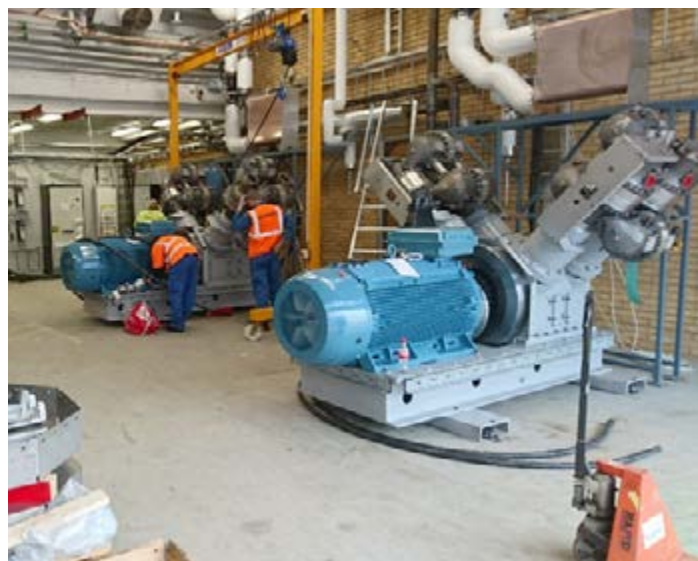
Slika 3: Zaključna faza vgradnje treh TČ SPP 4-160 v AstraZeneca, Stockholm.
